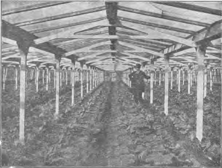
Fig. 77. — Vue inférieure d'un warenhuis - en béton armé avec plantation de choux-fleurs
